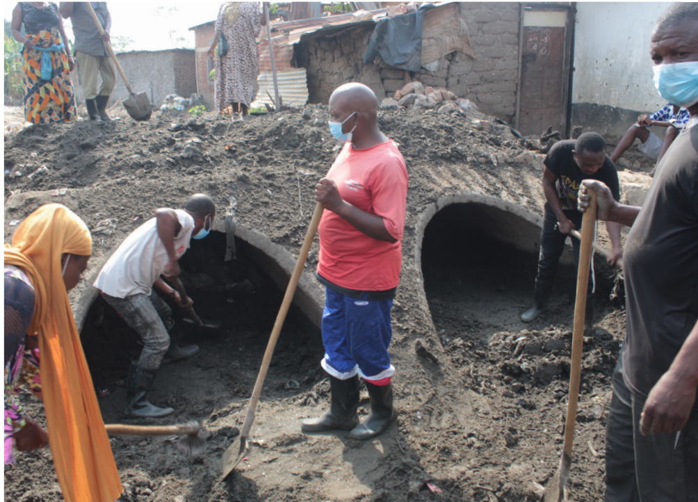
Travaux de débouchage des caniveaux
